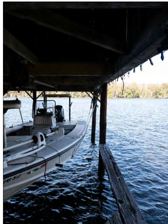
4 BOATHOUSE - NORTH INTERIOR SCALE: N.T.S.
